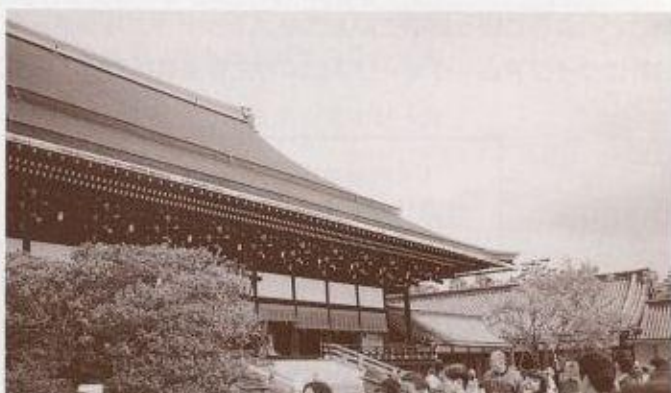
●京都御所紫宸殿 ちょうど一般公開中。左近楼、右近楼の本家本元の御殿建築。整然と並ぶ繊細な垂木と、黒く圧倒的な大屋根のコントラストが秋空に映える。巨大建築が権威の象徴であった往時の、宮大工棟梁の逞しき雄々しさへ思いを馳せる。
