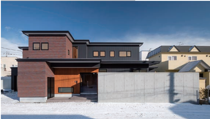
軒の出を確保し、シャープな印象に。建物高さを低く抑え、水平基調を意識し、フラット屋根にしている
