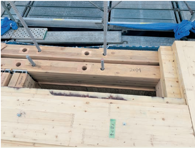
床トドマツCLTと下階横架材・壁パネル 壁内を貫通して横架材からタイダウンが伸びている様子
