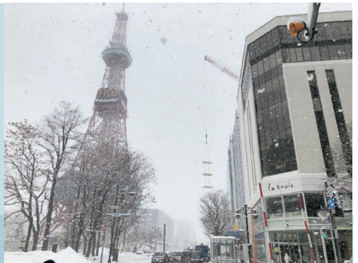
雪の中タワークレーンによる揚重風景
