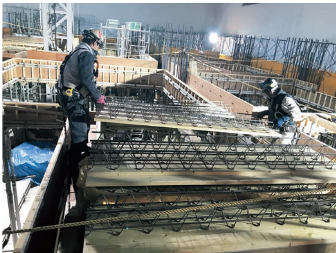
配筋付製材（MIデッキ）施工状況
