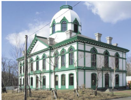
札幌市厚別区に再現された旧開拓使札幌本庁舎
