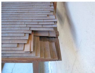
柿葺きの屋根。軒先の筋が入られた板の意味は？
